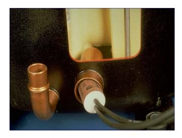
La figura muestra un Calefactor de Cárter de inserción en la línea "C". Es, en realidad, una resistencia eléctrica del tipo NTC que se autoregula en función de la temperatura ambiente (mayor resistencia a una menor temperatura ambiente). Este tipo de calefactores previene la migración de gas refrigerante hacia el aceite del compresor durante largos períodos de parada, evitando los denominados arranques inundados.
